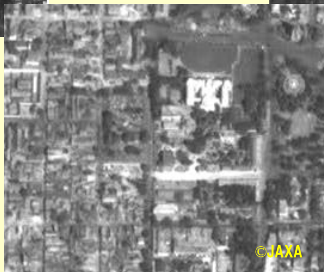
都市部の建物被害
