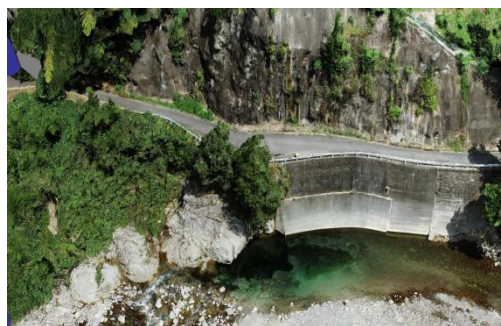
図3：UAVレーザと写真測量合成例
